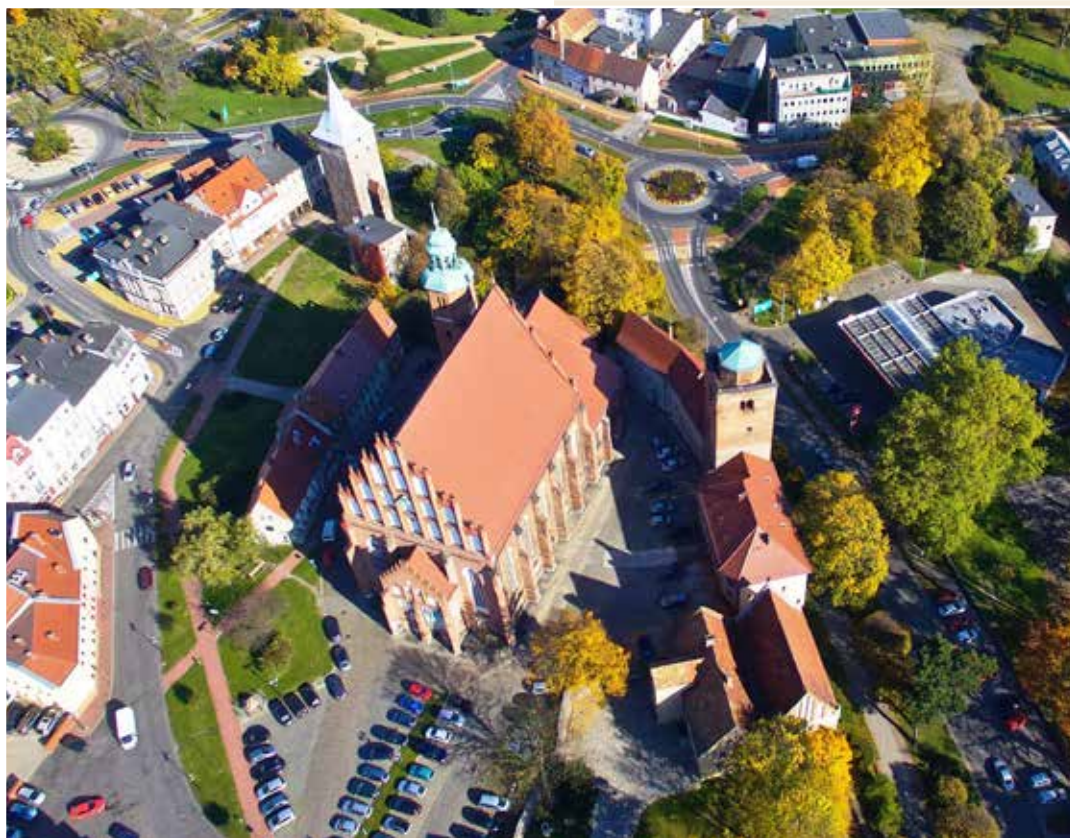
Kościół farny, muzeum, wieża wartownicza z góry. Pfarrkirche, Museum, Wächterturm von oben.
